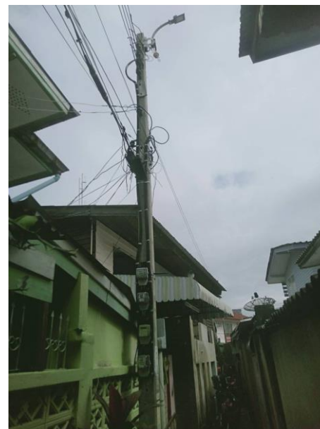
ก่อนดำเนินการ
