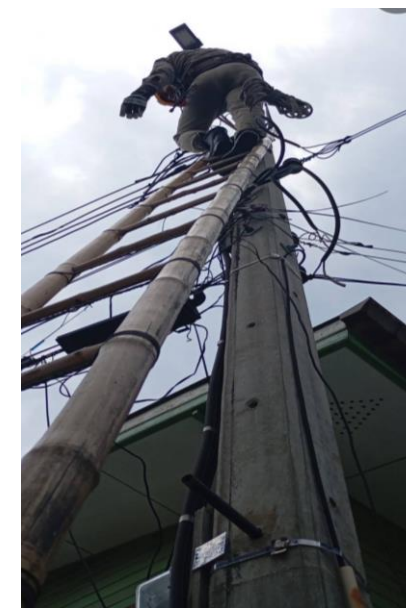
หลังดำเนินการ
