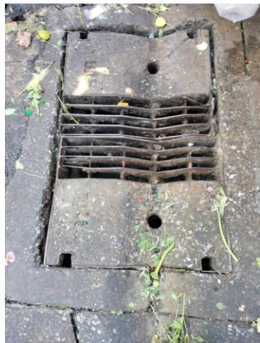
ก่อนดำเนินการ
